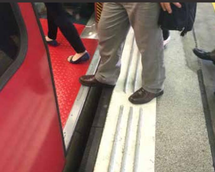
La plataforma Gap Filler es un perfil de goma resistente y robusto que se monta a lo largo del borde de una plataforma de tren para reducir el espacio entre la plataforma y la entrada de un tren de pasajeros; garantizando que cuando un tren se detiene en un andén, los pasajeros puedan entrar y salir con seguridad.
